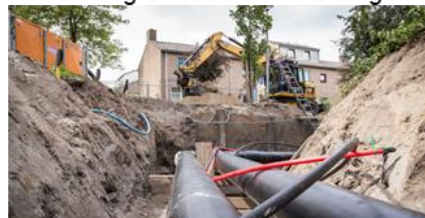
Ondergrondse warmteleidingen
